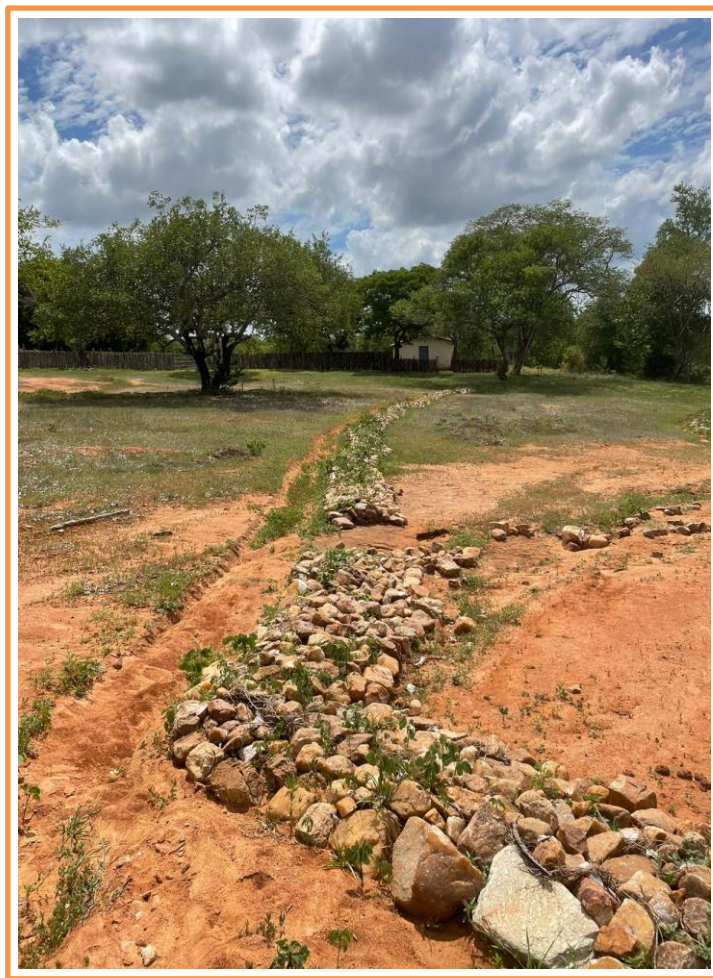
Figura 11: Mediante o evento da chuva, os sedimentos carreados foram barrados pelos cordões de pedra. Contudo, a barreira rompeu mediante o acúmulo de material. Com isso, recomenda-se a manutenção necessária. Fonte: Noely Viana.
