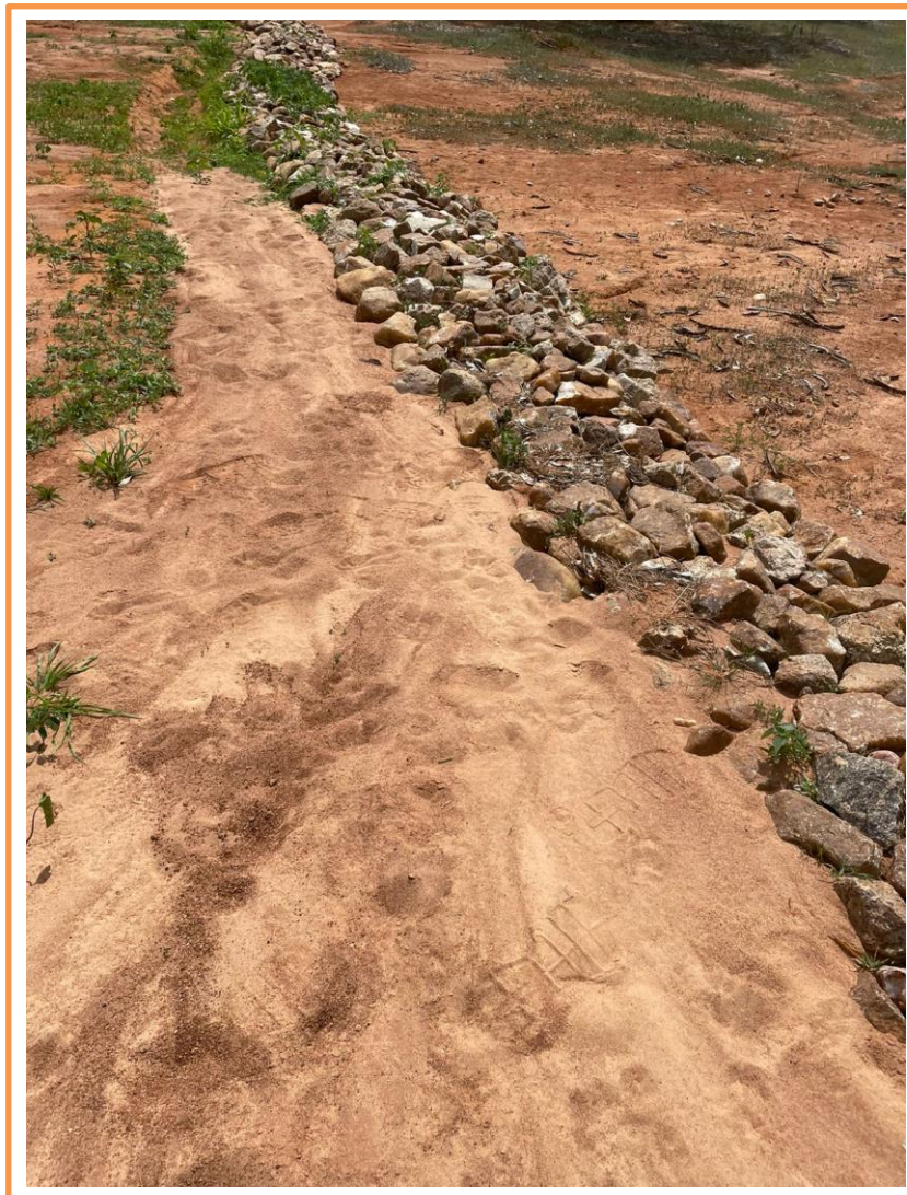
Figura 10: Sedimentos que foram carreados das áreas mais altas foram retidos pelos cordões de pedra. Com isso, há a necessidade de retirada desse material para que o cordão de pedra não sofra danos, como rompimentos. Fonte: Noely Viana.
