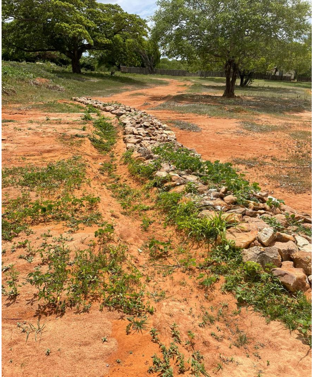
Figura 8: Abertura do sulco (vala) e o cordão de pedra seguindo-o sinuosamente na Fazenda Não Me Deixes, Quixadá-CE. Fonte: Noely Viana.
